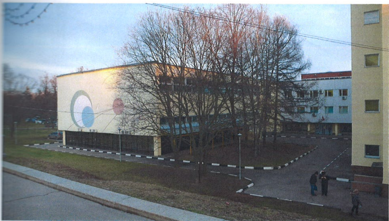
Фото № 16. Вид на "Корпус со спортзалом, административными помещениями", газоны и лиственные посадки.
