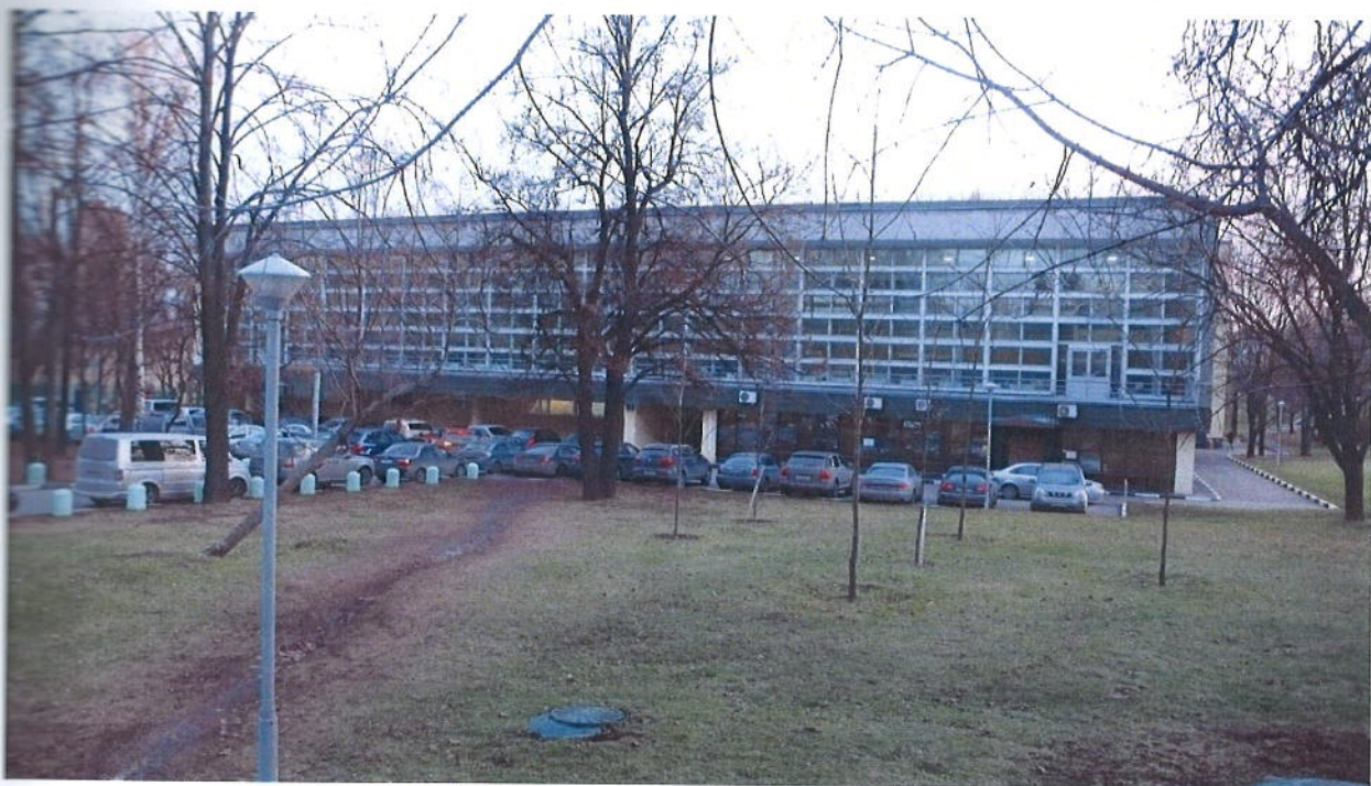
Фото № 18. Вид на "Корпус со спортзалом, административными помещениями", газоны и лиственные посадки.
