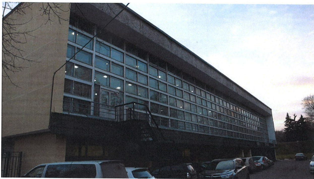
Фото № 19. Вид на "Корпус со спортзалом, административными помещениями".
