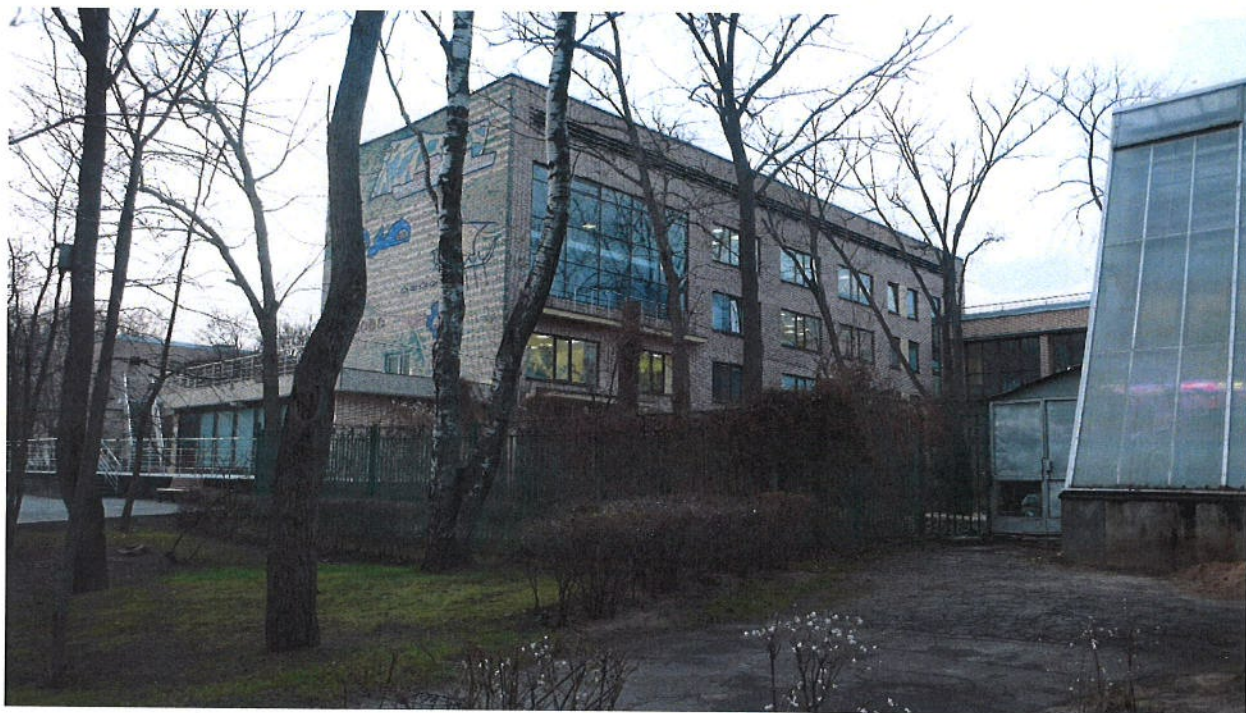
Фото № 6. Вид на "Корпус для кружковых занятий с панно "Вода" на парковом фасаде".
